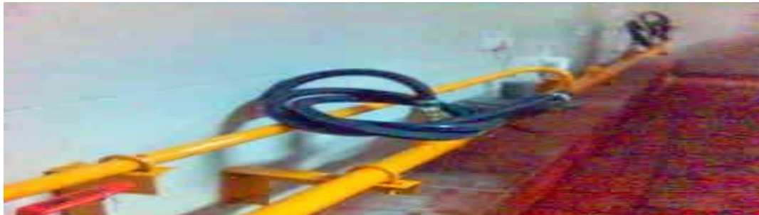
Jalur pipa gas
