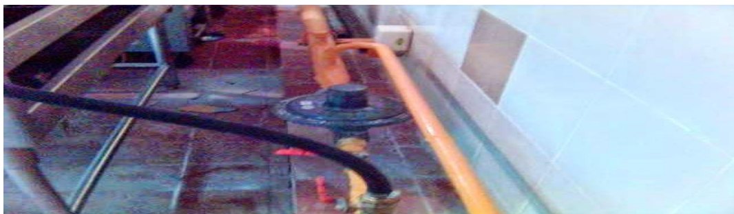
Jalur pipa gas
