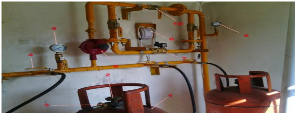
Instalasi sentral gas dan bagian – bagiannya
